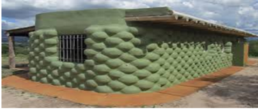
Utilisation des pneus pour construction
