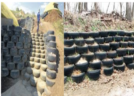
Utilisation de pneus en guise de soutènement de talus
