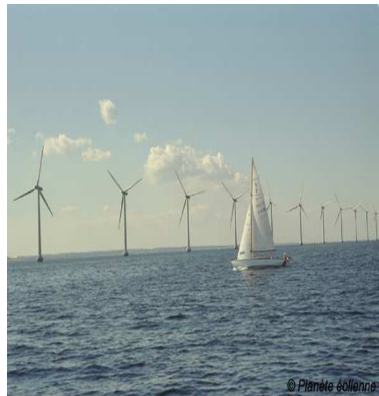
Figure 3.7: Les éoliennes en pleine mer
