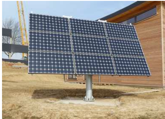
Figure 2.5: Système avec poursuite solaire
