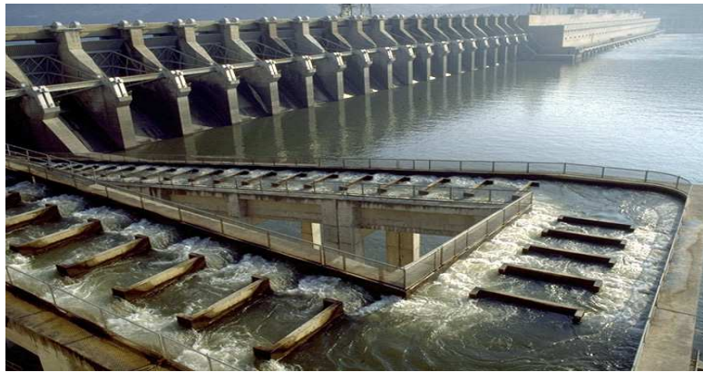
Figure 4.3: Grande échelle à poissons d'un barrage
