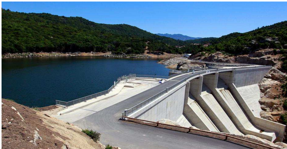
Figure 4.1 : Le barrage de la centrale hydroélectrique
