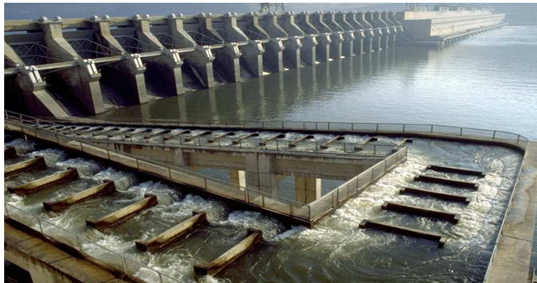
Figure 4.3: Grande échelle à poissons d'un barrage
