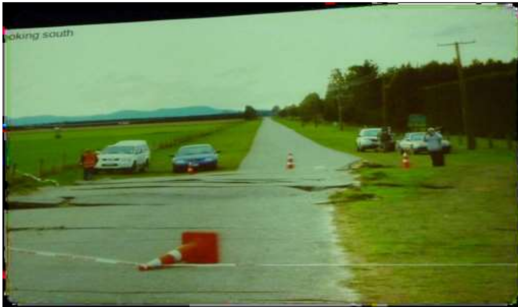
Figure 3 : la route est décalée dextre de 4,5 m (Christchurch, Nouvelle Zélande, 4/09/2010)
