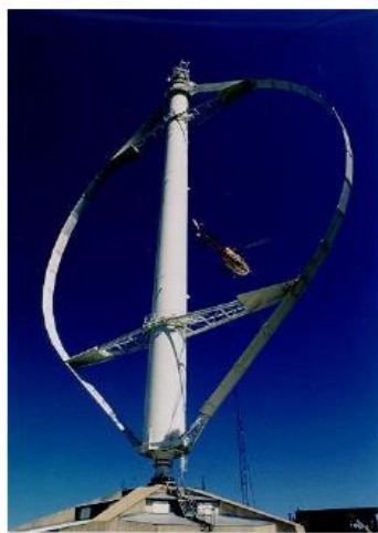
Éolienne de type Darrieus.
