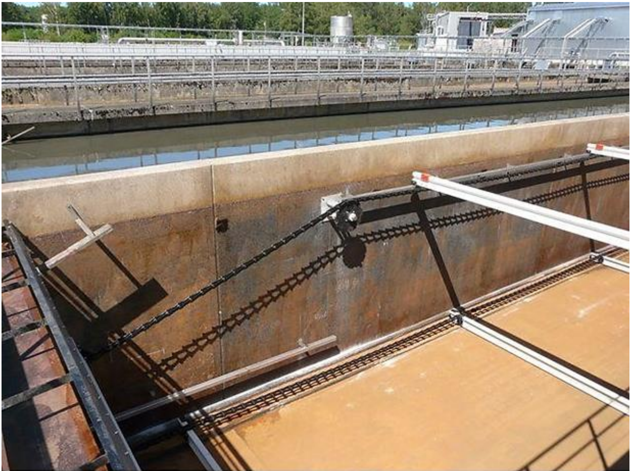
Figure III.2 : Dessableur longitudinal
