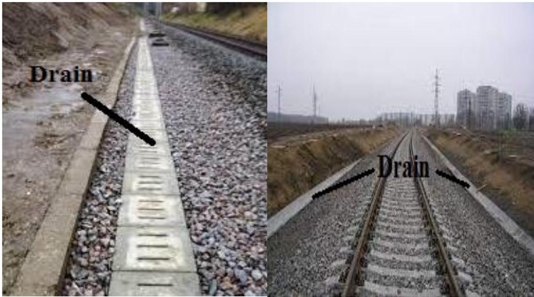
Figure 2 : Exemples d'assainissement longitudinal.
