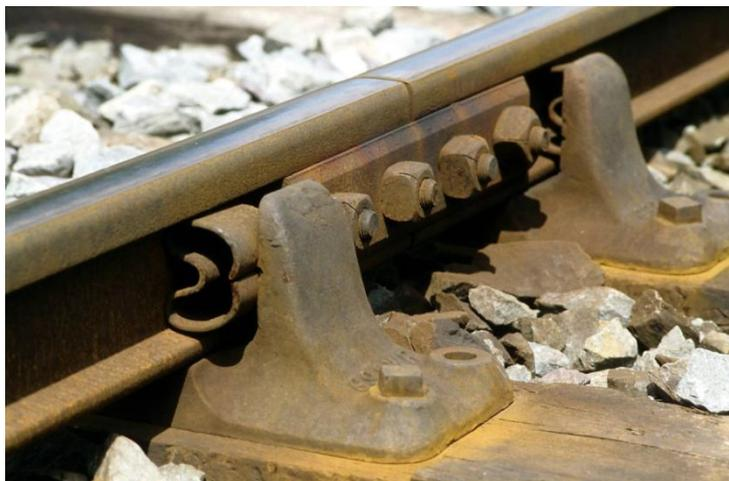
Figure 24 : Système de fixation des rails aux traverses en bois.
