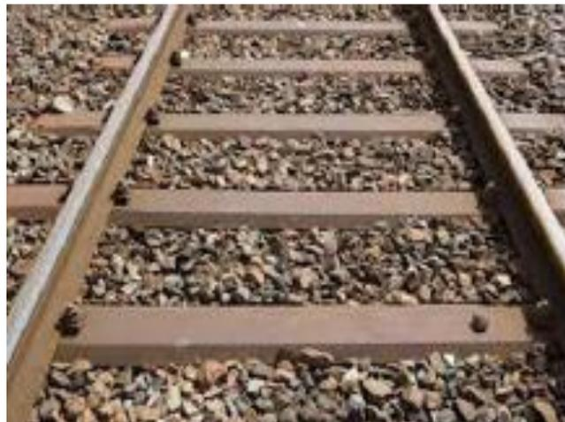
Figure 16 : Modèle d'une traverse métallique.
