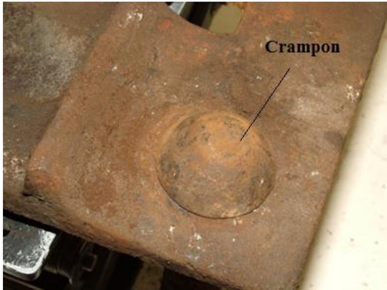
Figure 17 : Vue du dessus de la tête d'un crampon à section arrondie.
