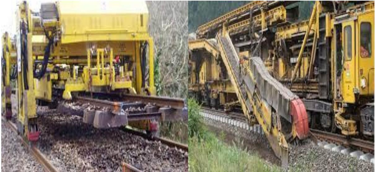
Figure 4 : Machine à fabriquer les voies « MATISA P95 GCF.
