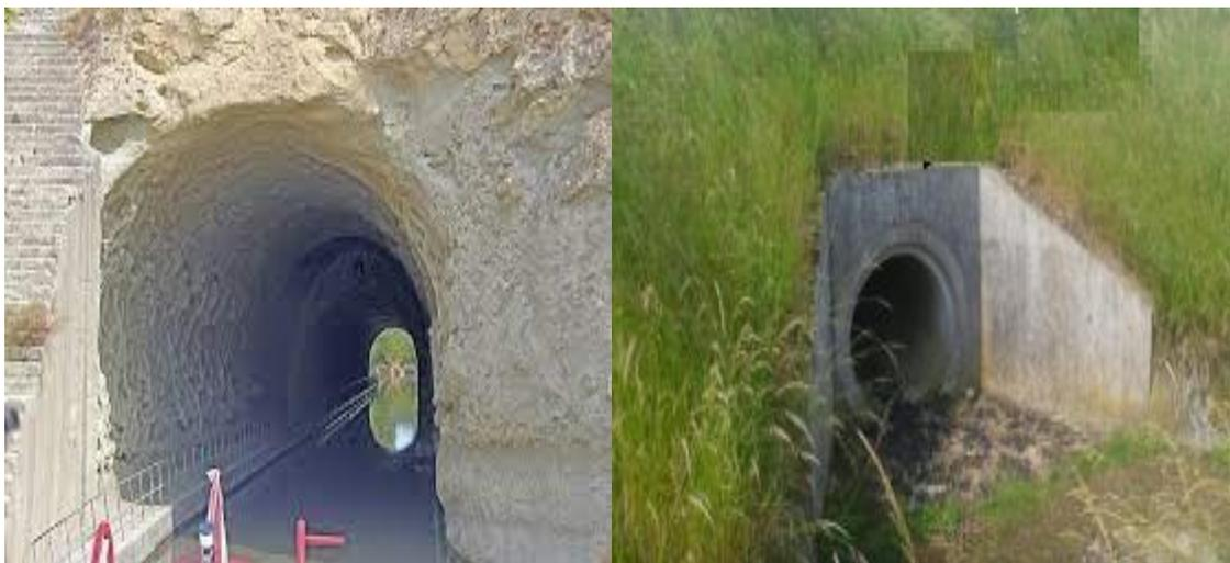
Figure 1 : Exemples d'assainissement transversal.
