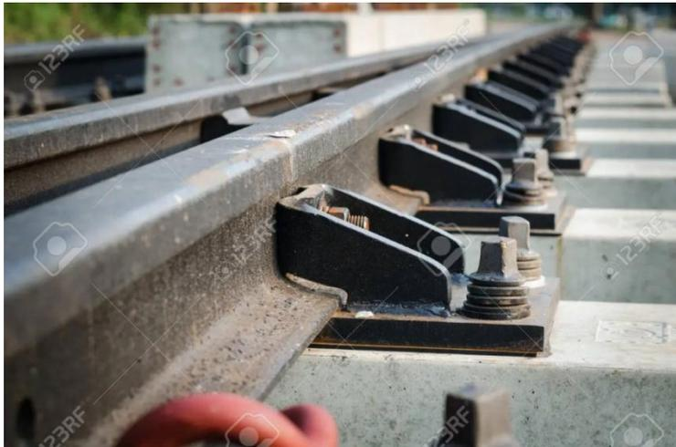
Figure 23 : Clips en acier pour fixation de traverses en béton.
