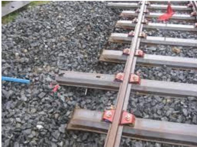
Figure 25 : Système de fixation des rails aux traverses métallique.
