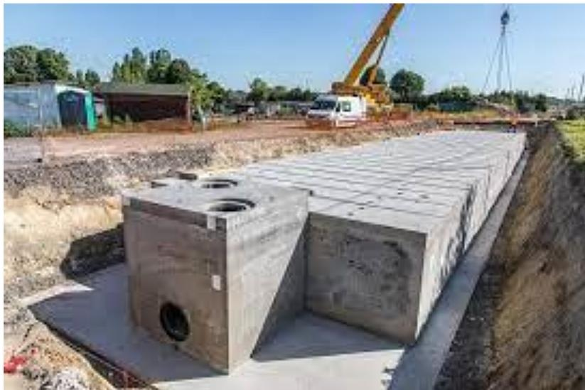
Figure 14 : ouvrages de stockage et de rétention.
