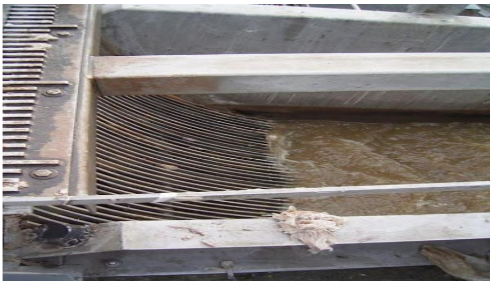
Figure IV.1 : Le dégrillage
