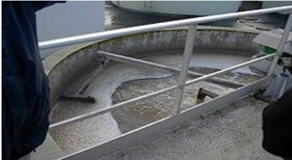
Figure IV.4 : Le dégraissage
