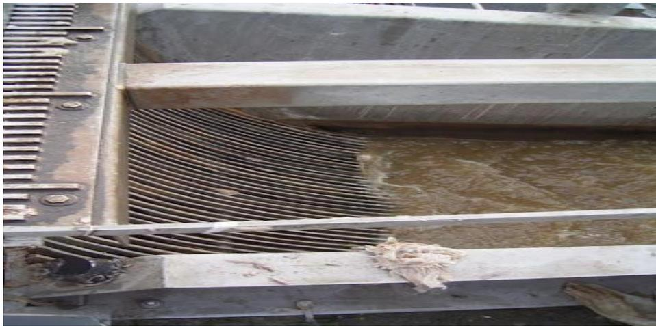
Figure III.1 : Le dégrillage
