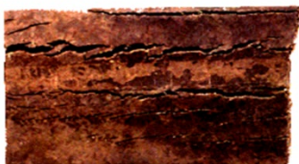
Fissures de CSC
