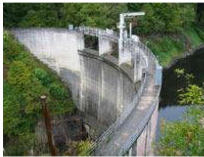
Figure 8: Barrage de Luzège
