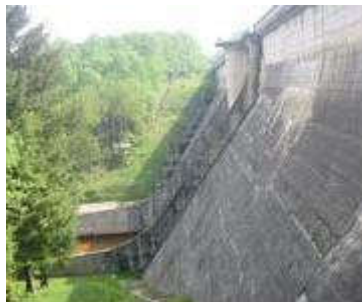
Figure 6 : Barrage de Vassivière
