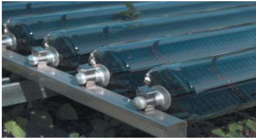
Figure 6 : Détail d'un capteur solaire sous vide.
