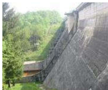
Figure : Barrage de Vassivière
