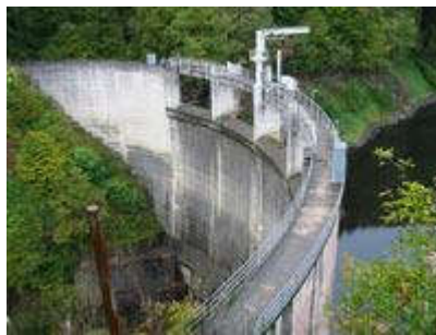
Figure : Barrage de Luzège
