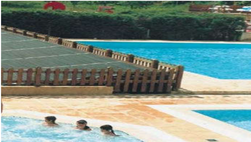
Figure : Piscine publique utilisant des capteurs souples.
