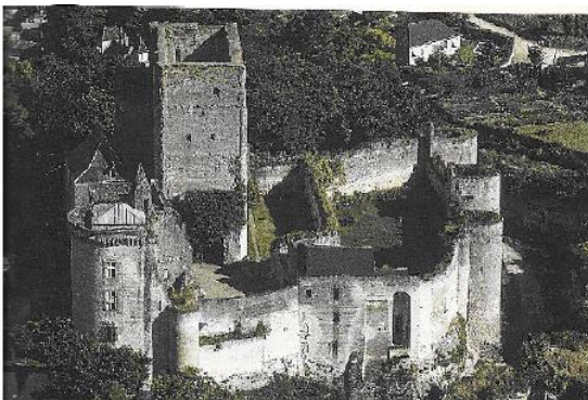
Château de Loches (construit entre 1013 et 1035) Château du Moyen Age.
