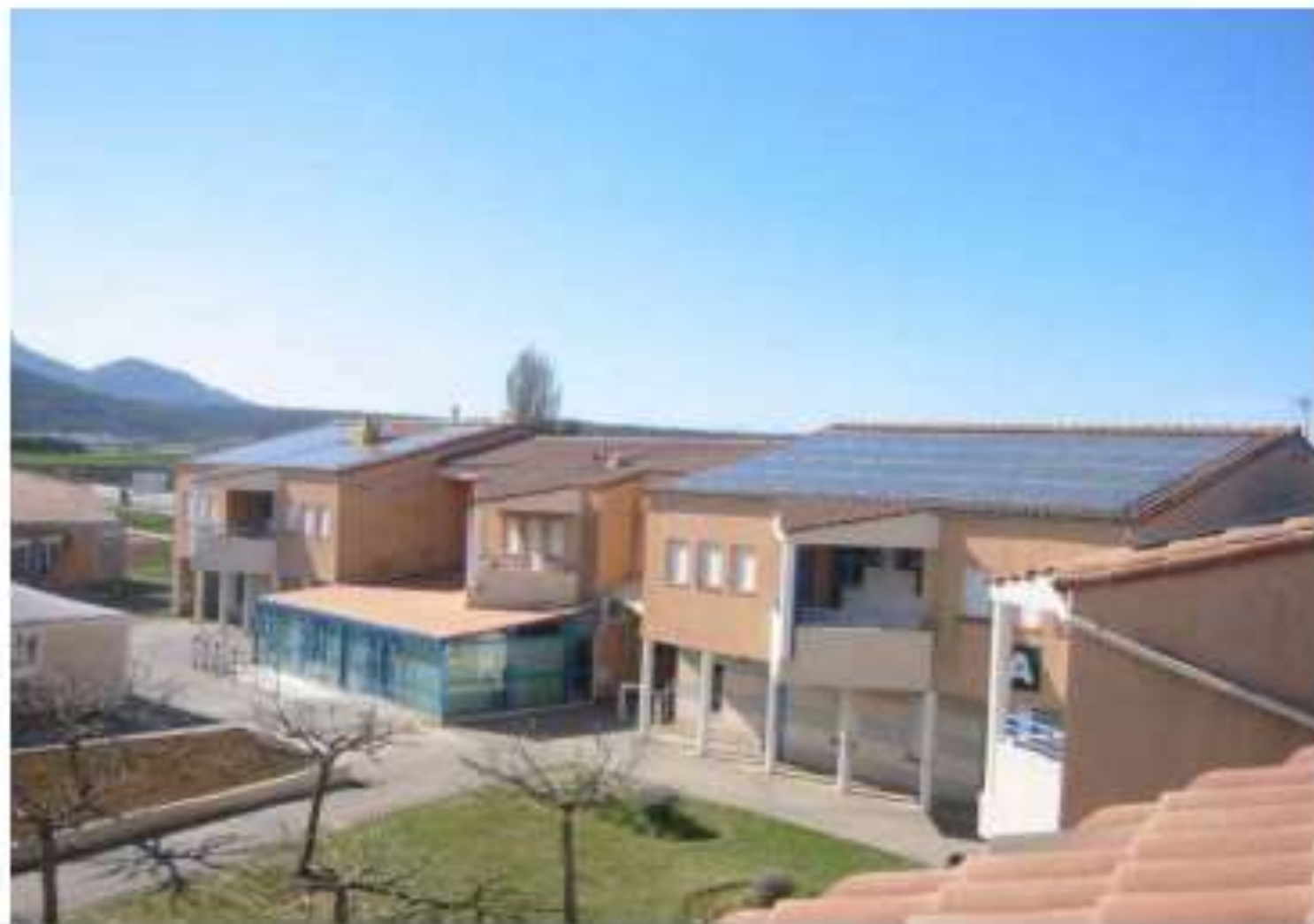
Vue du lycée d'enseignement agricole professionnel de Saint Maximin équipé de panneaux photovoltaïques. Source : ENEOVIA
