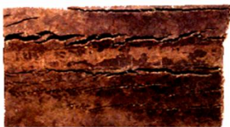
Fissures de CSC
