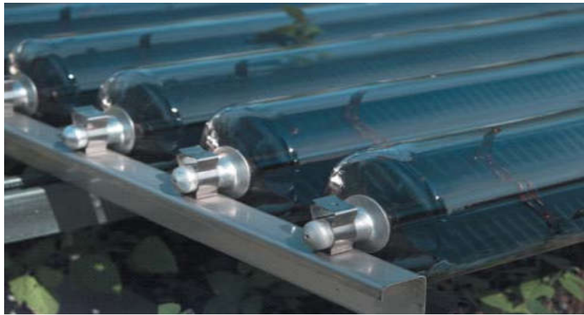
Figure 6 : Détail d'un capteur solaire sous vide.
