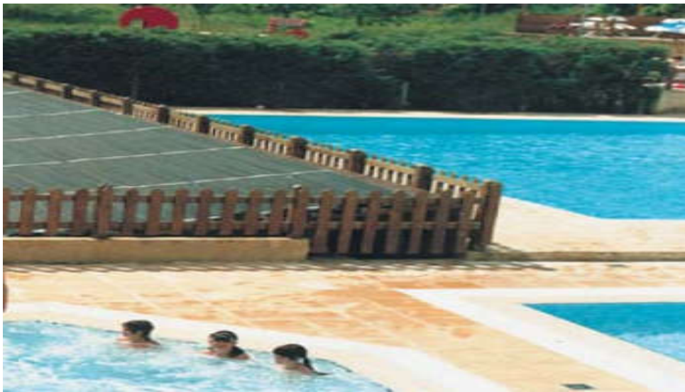
Figure 3 : Piscine publique utilisant des capteurs souples.
