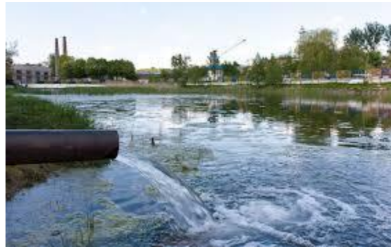
Figure 10 : Déversement des eaux chaudes dans le milieu aquatique
