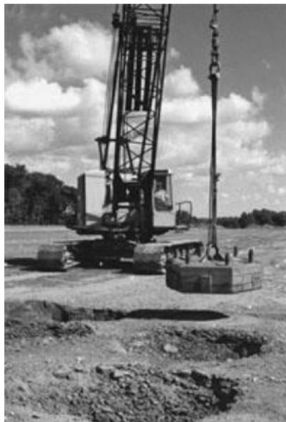
Figure 3.7 : Compactage dynamique. (Photo gracieuseté de Terra Systems, Inc.)
