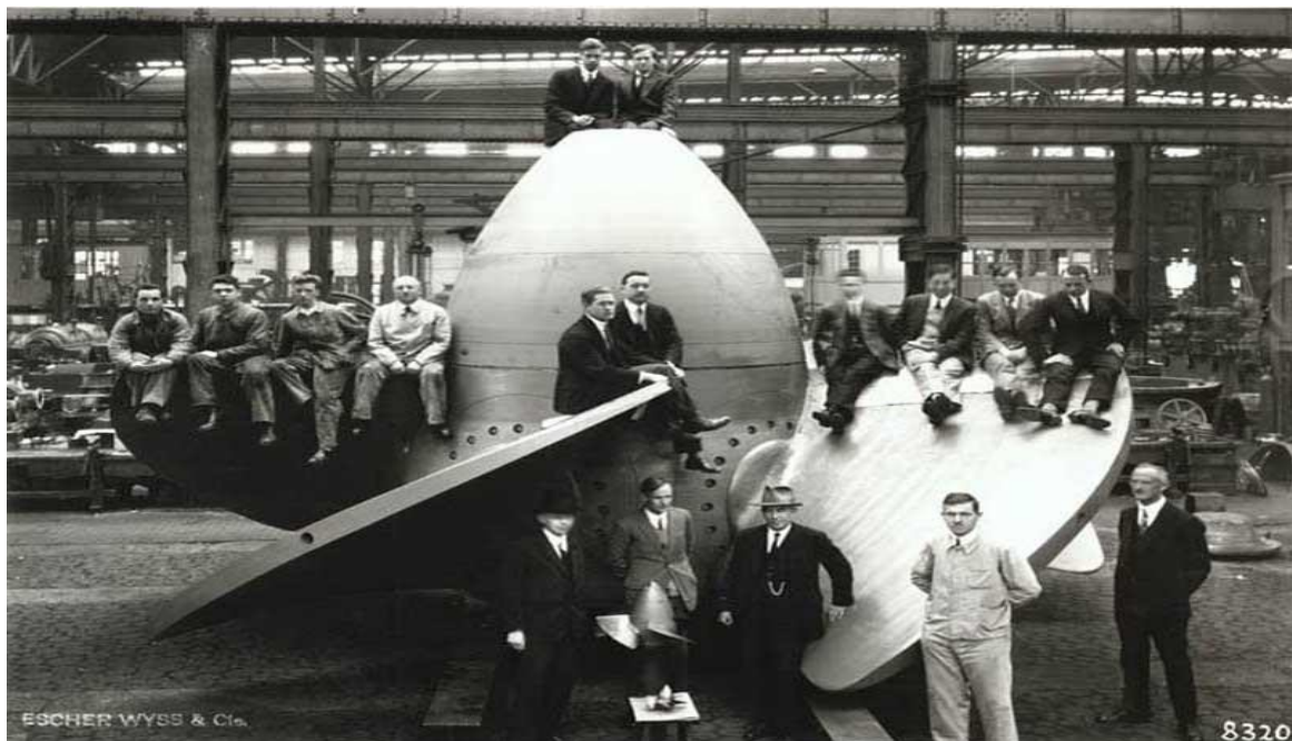
Figure 5.7 : Roue de Turbine Kaplan
