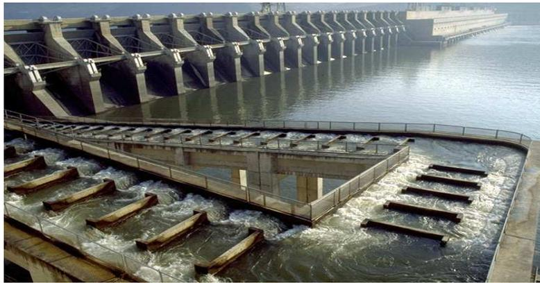
Figure 4.3: Grande échelle à poissons d'un barrage
